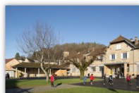
Groupe scolaire "Simone-Veil" - restructuration et extension, Montmorot (39)
