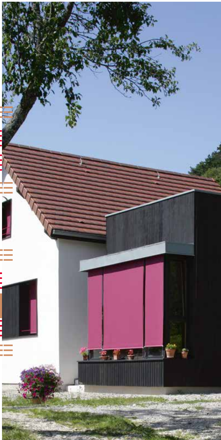
Maison des Ragots - 2006 - Atelier d'architecture Tardy
