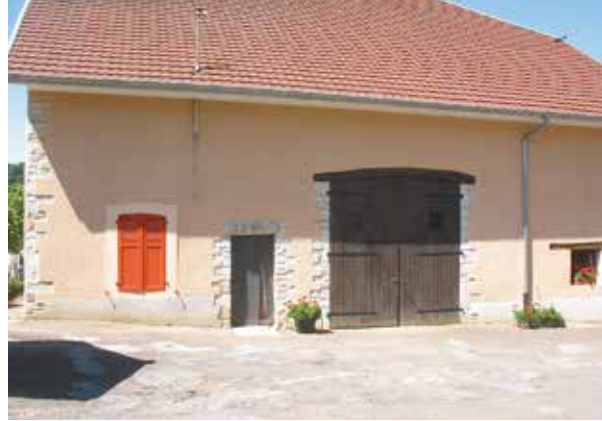
Enduit en épaisseur
