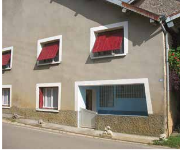
Ouvertures modifiées / occultants non adaptés
