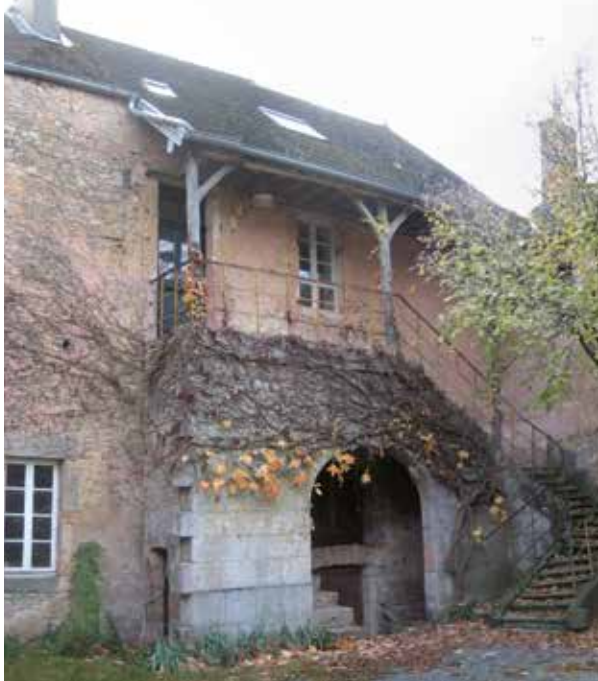
B. Cohendet, architecte - Rénovation d'une maison ancienne, Rainans (39)
