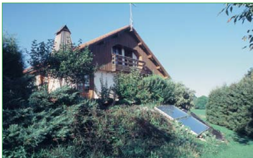
Chauffe-eau solaire à Villers-le-Lac (Doubs)
