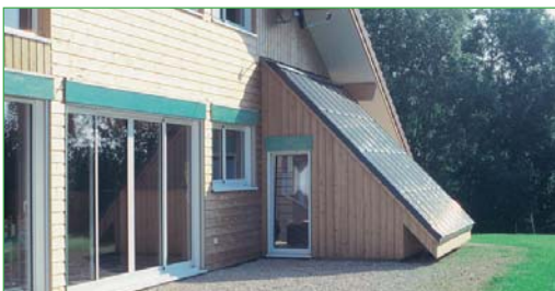
Chauffage solaire (16 m 2 de capteurs)
