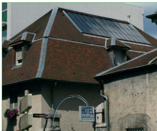
Eau chaude solaire collective
