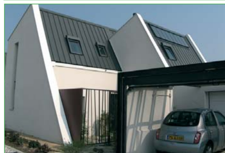
Chauffe-eau solaire de 4 m 2 à Saint-Priest (Rhône)
