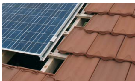
Principe d'intégration des capteurs à la toiture
