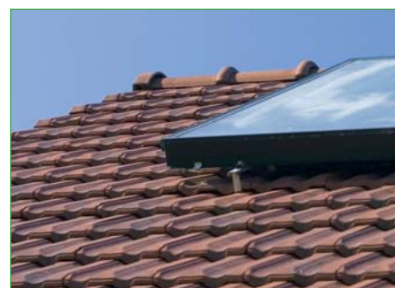
Détail de la fixation en surimposition
