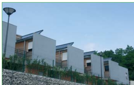
Eau chaude solaire collective
