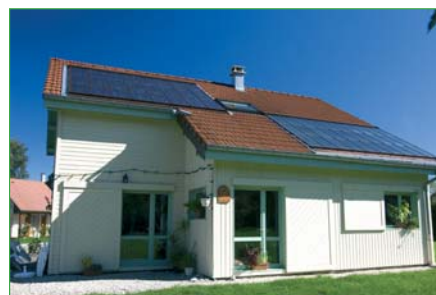
Chauffage solaire et photovoltaïque à Naisey-les-Granges (Doubs)
