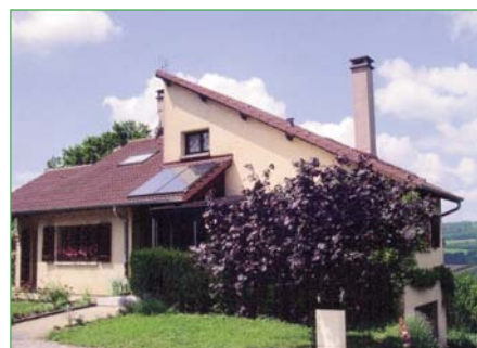
Chauffe-eau solaire à Baume-les-Dames (Doubs)
