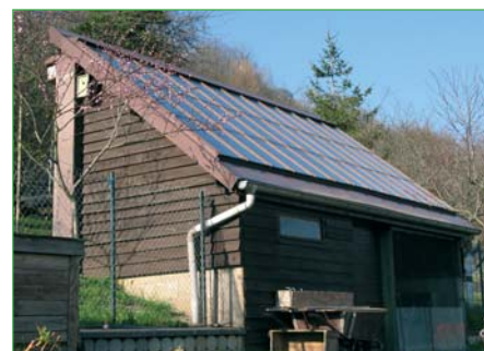
Chauffage solaire à Besançon
