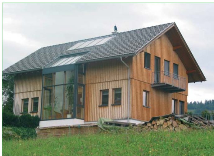
Chauffe-eau solaire dans le Voralberg (Autriche)
