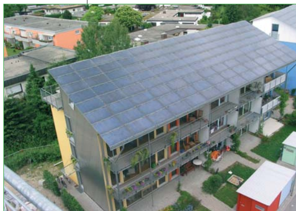
Photovoltaïque à Fribourg (Allemagne)
